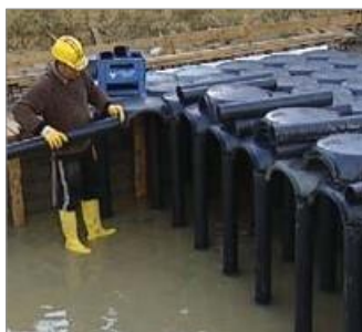
Detalii despre secvențele complete de instalare a sistemului Atlantis 50x50 cm.
