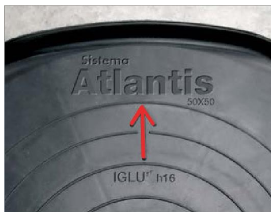
fig. 1 – Așezarea primului cofraj, săgeata este îndreptată spre bordura fundației
