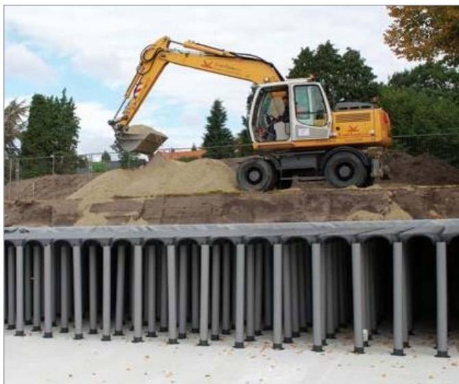
Rezervor de colectare a apei sub o zonă rezidențială
